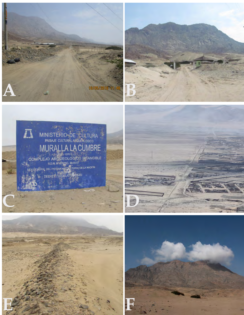
Fig. 5. A y B. Ingreso a la granja de pollos, C. Cartel del Ministerio de Cultura que protege la Muralla La Cumbre (Chimú), D. Vista panorámica de la Muralla La Cumbre (Chimú), E. Acercamiento de la Muralla La Cumbre (Chimú) evidenciando deterioro, F. ACP Lomas del Cerro Campana.
