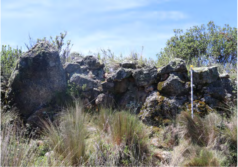
Fig. 13. Detalle de la construcción de los muros.
