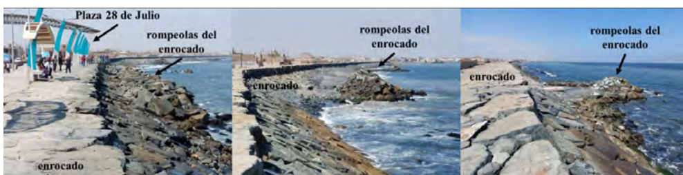
Fig. 5. Enrocado y formas de rompeolas del enrocado, de la bahía El Ferrol, en el frente y sur de la plaza 28 de Julio (fotos mayo de 2022).
