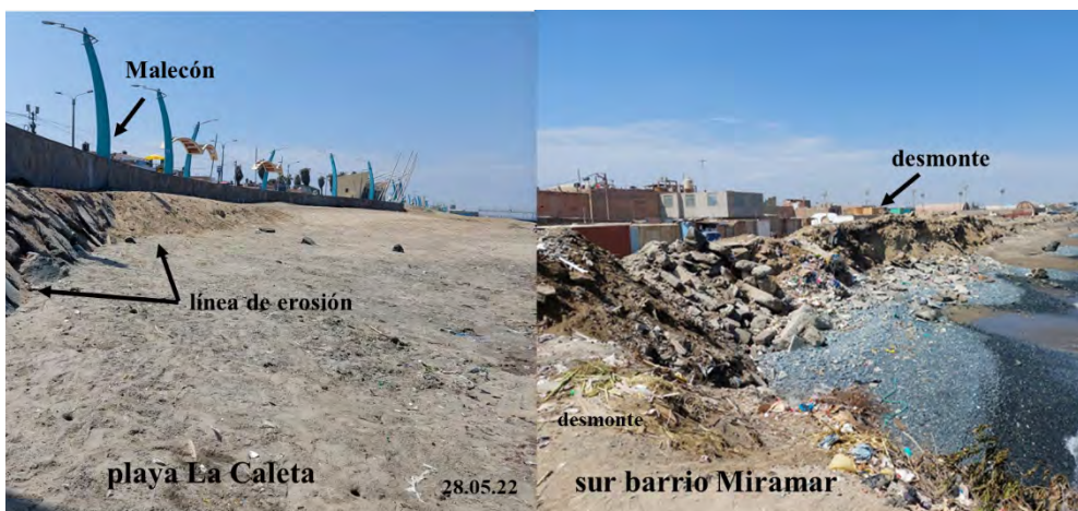
Fig. 6. Línea de erosión de la bahía El Ferrol en el extremo sur de la playa La Caleta, y acumulación de residuos de la construcción (desmorte) para contener el proceso erosivo al sur del barrio Miramar (fotos mayo de 2022).
