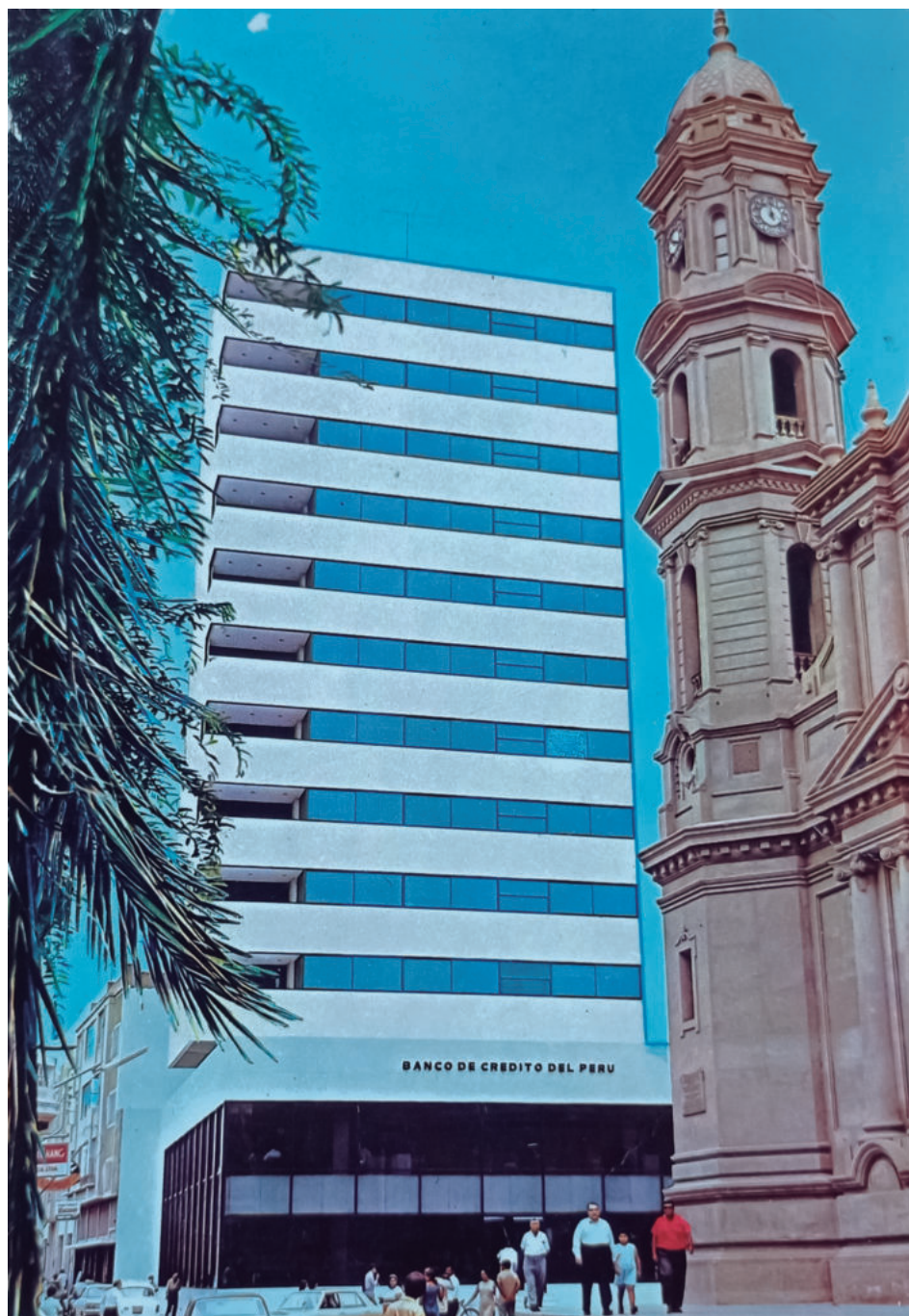
Figura 1. Edificio sede del Banco de Crédito en Piura días antes de su inauguración (1968). Registro fotográfico del Sr. Arturo Davies Guaylupo.
