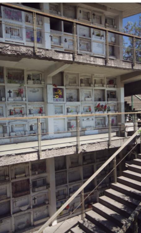
**Figura 9. Deterioro de las losas de hormigón de los nichos del sector Norte del Cementerio General de Santiago de Chile.** Fotografía del equipo de investigación del proyecto Fondo I+D de Fomento a la Investigación de la Universidad Central de Chile, proyecto n.º 0162019. Investigador responsable: Marco Valencia, 2021.
