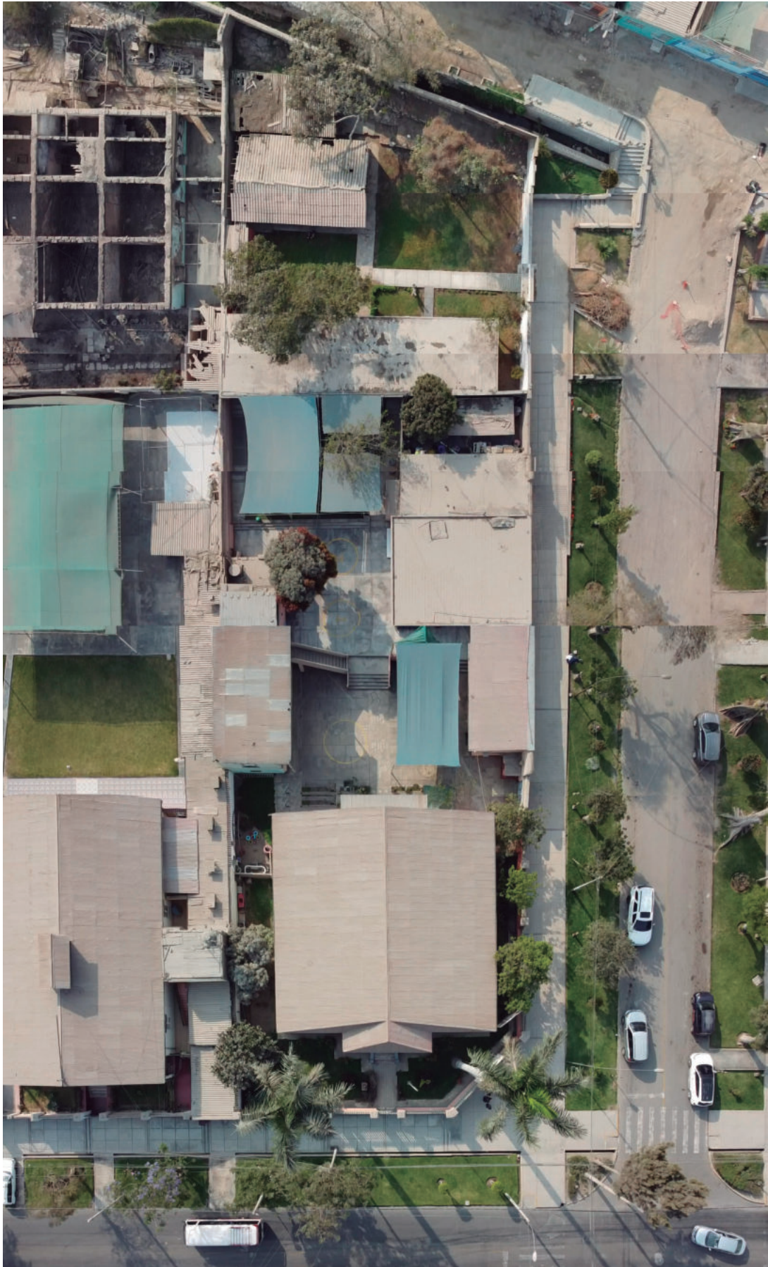
Figura 7. Fotografía aérea del edificio de estudio (2021)
