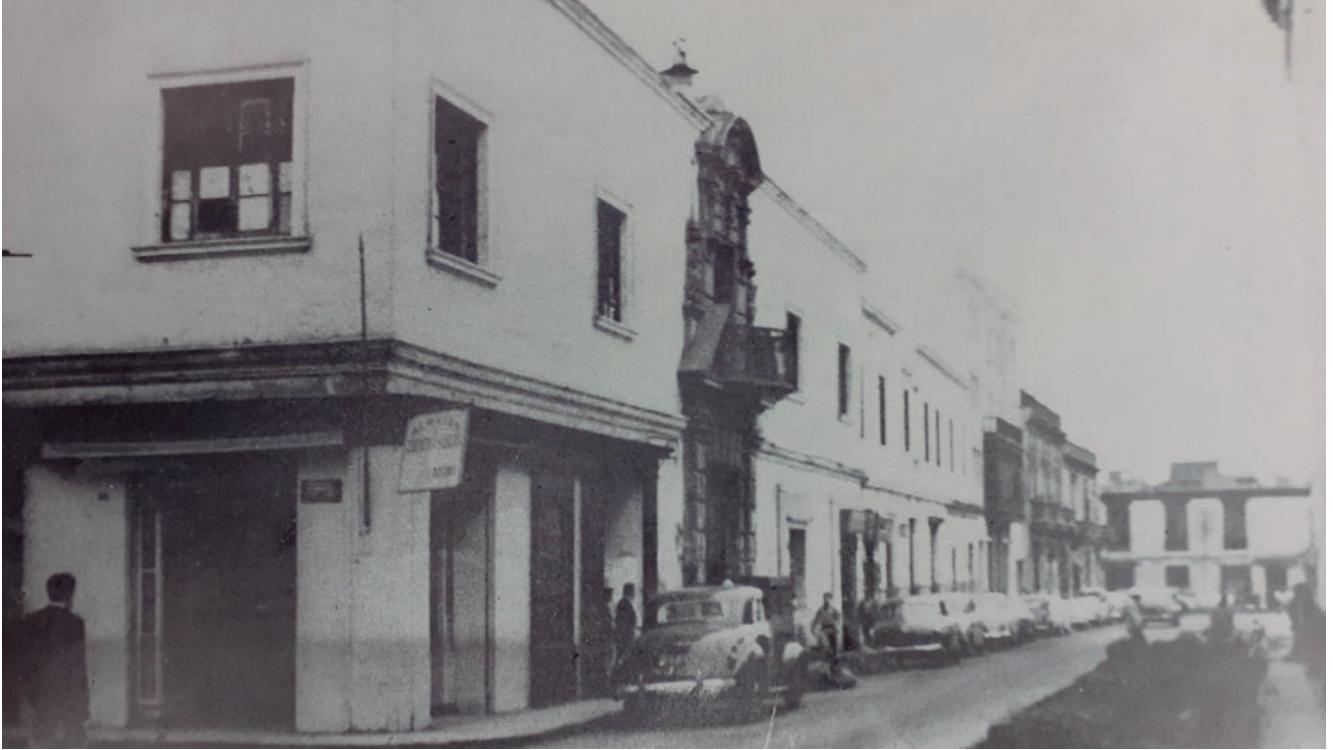
Figura 4. Vista de la casa sin balcones anterior al proyecto de restauración de 1963. Adaptado de “Vista de la casa sin balcones antes del proyecto de restauración” (p. 16), por Héctor Velarde, 1963, Revista Peruana de Cultura, I.
