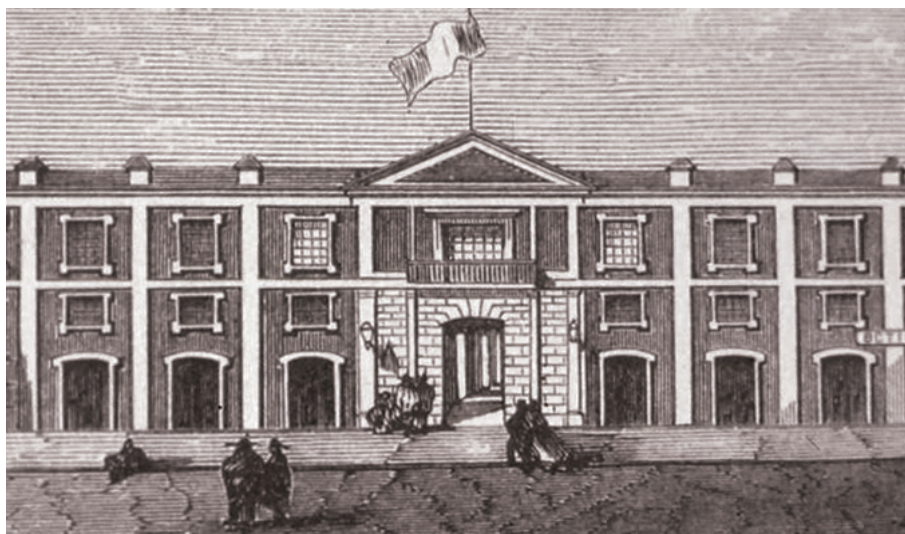
Figura 3. La fachada del Colegio de Medicina de San Fernando.
